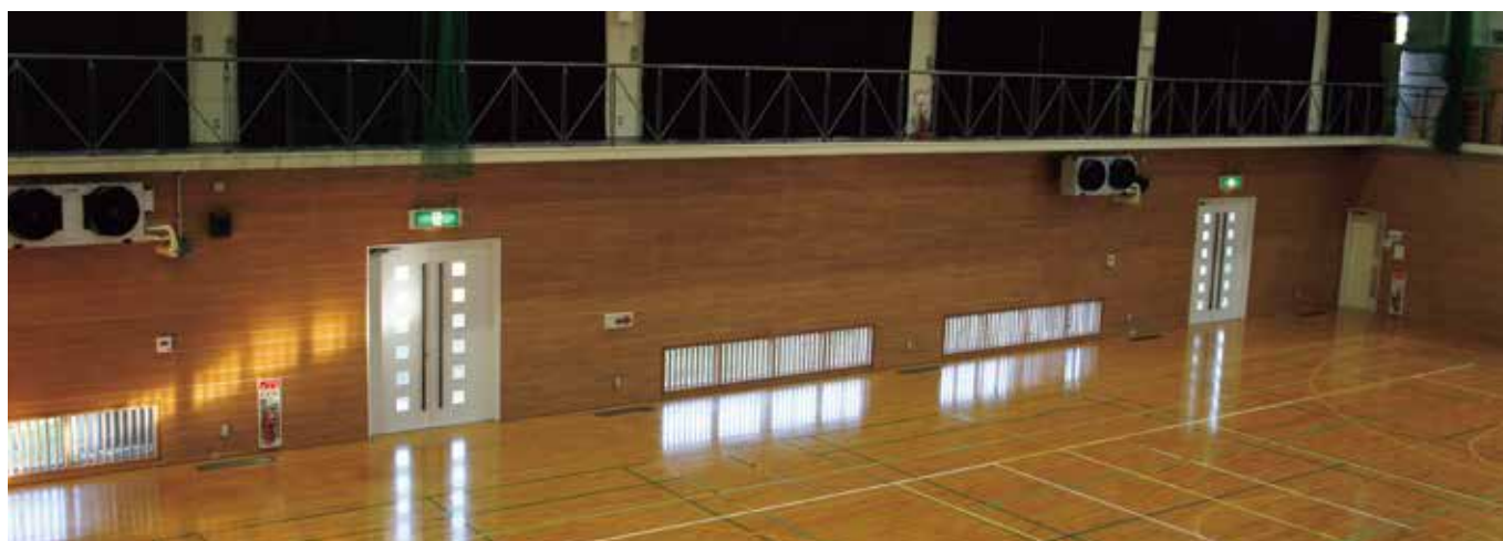
エリア空調機は天吊設置でキャットウォークの下に取付け
